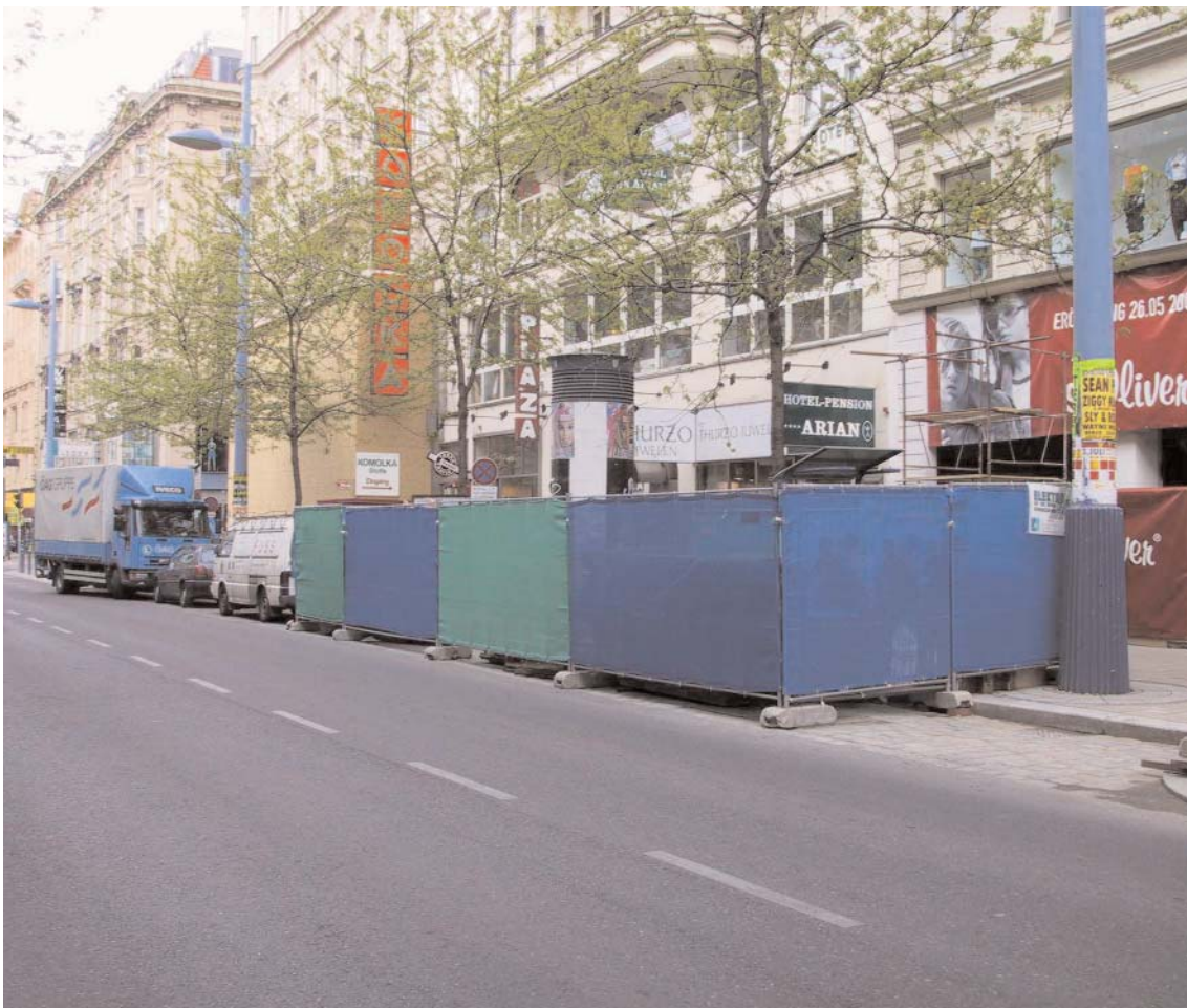
Building site Mariahilfer Straße, Vienna
